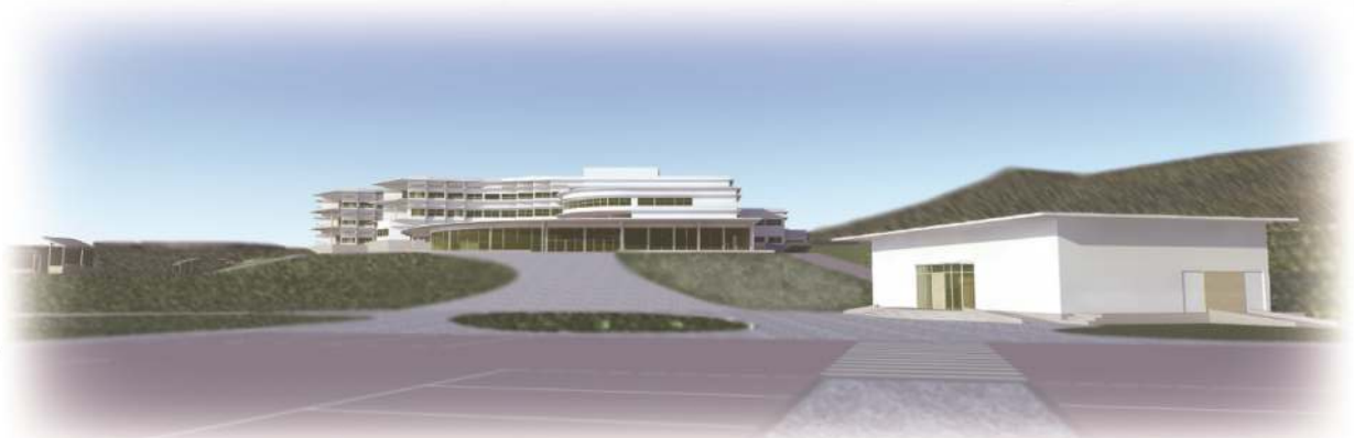
外来診療用駐車場から病院方向を見る
